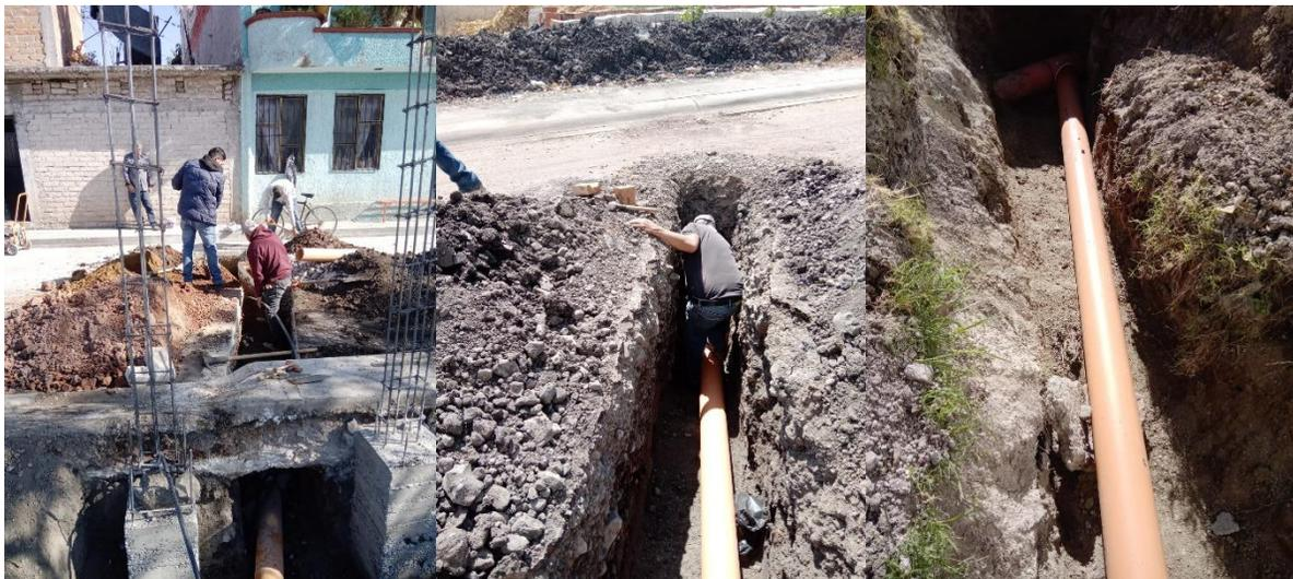
**Reparamos 47 baches generados por los diferentes trabajos de fontanería realizados por la rehabilitación, y conexión de tomas de agua potable y drenaje, garantizando que los trabajos se realicen de manera correcta y segura.**
