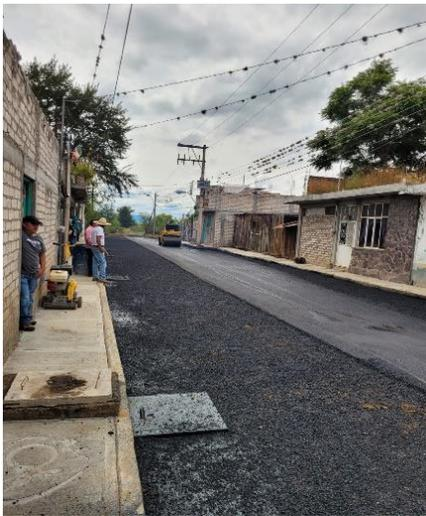
♡ Construcción de 104.70 metros cuadrados de banqueta a base de concreto hidráulico de 10 cm de espesor.
