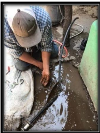
Realizamos las acciones necesarias para detectar y reparar las fugas o fallas en las tomas de agua reportadas y encontradas, así como en la red principal de distribución, de igual manera brindamos el servicio para sopletear las tomas de agua afectada por el taponamiento a consecuencia de la acumulación de arenas y la formación de sarro en los domicilios solicitados o en las tomas requeridas.
